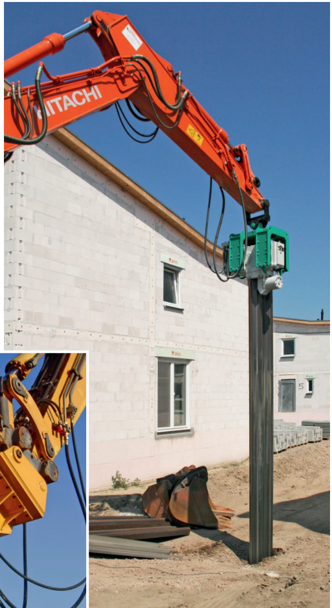
Bild: Anbauvibrator HVR 45 angebaut über Standard-Adapter
